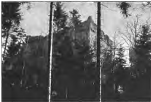
Fig. 49. Kürnberg. Ansicht des Hauptbaues (10) der Burgruine.
